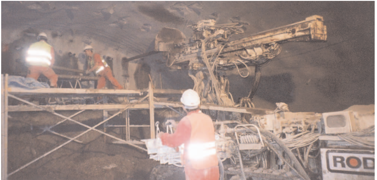
Fig. 20. Realización de perforaciones para el tratamiento.
