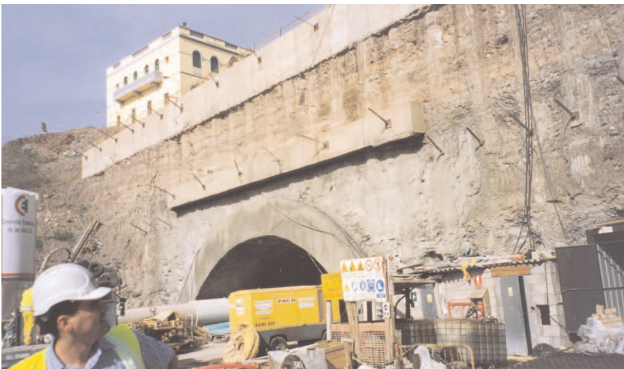
Fig. 6. Emboquille lado mar.
