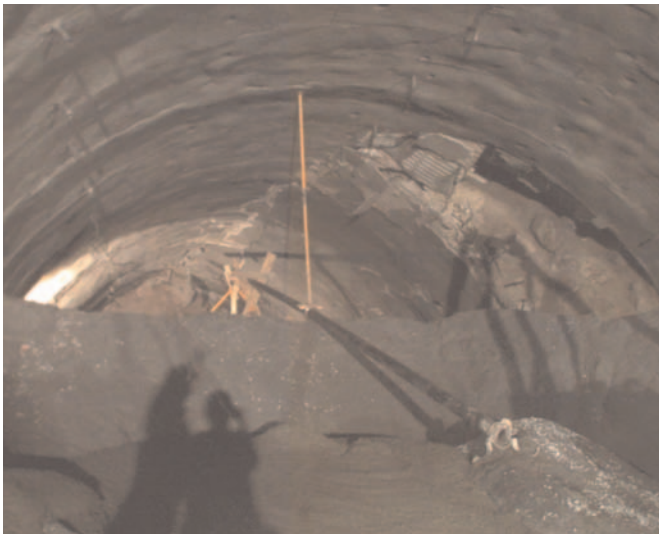
Fig. 17. Hormigonado de la parte inferior del tapón de cierre, lado tierra.
